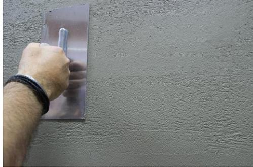
Die optische Einteilung der Fugenstreifen zur Erstellung der Sichtbetonoptik erfolgt nach eigenem Ermessen. Das Erzeugen der Linien erfolgt durch das Anlegen einer H-Latte etc. und dem Entlangfahren mit einer Kelle oder Lanzette. Die gewünschte Fugenausbildung zeigt sich individuell nach Handschrift des jeweiligen Verarbeiters.
